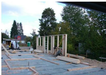
Beginn des Anbaus im Sommer 2008
